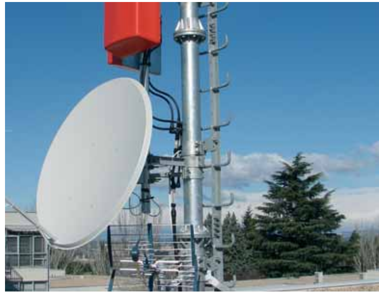
Sistema radiante situado en la azotea de la ETSIT. Instalación realizada por DETECMA.
